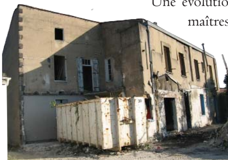
©CETE Sud Ouest Chantier plomb SAEMCIB
