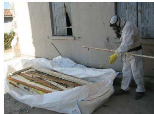
©CETE Sud Ouest Chantier plomb SAEMCIB
